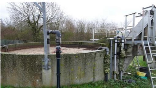
4- bassin d'aération : les matières organiques sont dégradées par des bactéries et deviendront des boues. Une forte concentration d'oxygène est entretenue au moyen d'aérateurs qui maintiennent la boue en suspension.
