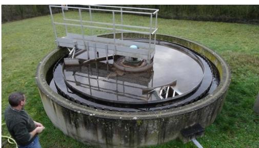
6- clarificateur : les boues produites lors du traitement biologique s'accumulent au fond, sont séparées de l'eau et seront dirigées vers le puits à boues. L'eau épurée restée en surface sera rejetée dans le Ru de Guiry
