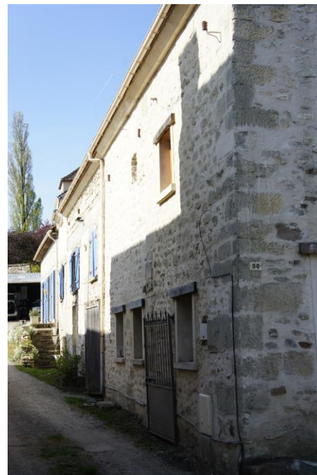
Façade est du bâtiment (2), sur cour (c)
