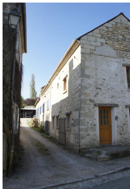
Accès (a) – Pignon sur rue bâtiment (2)
