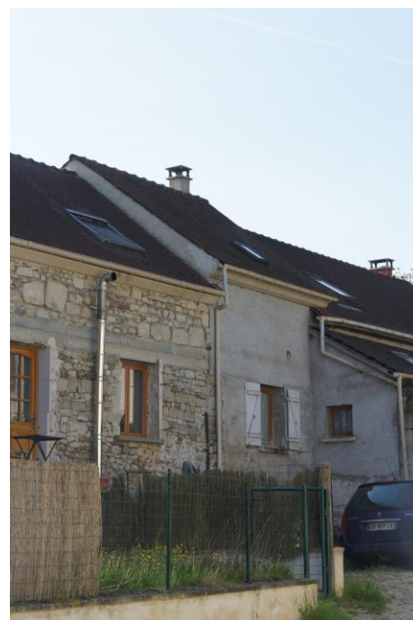
Façade ouest du bâtiment (2), sur cour(b)
