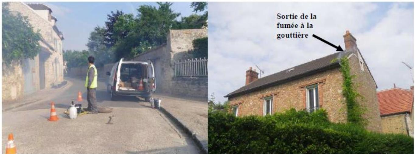
Figure 55 : Présentation du dispositif d'injection et réapparition à la gouttière du 2 rue Calvin (hameau d'Enfer)
