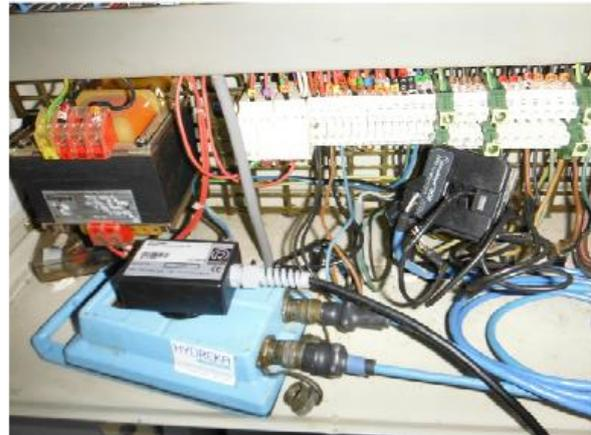
Figure 30 : Installation des pinces ampèremétriques sur l'armoire du poste de refoulement à la station d'épuration d'Enfer
