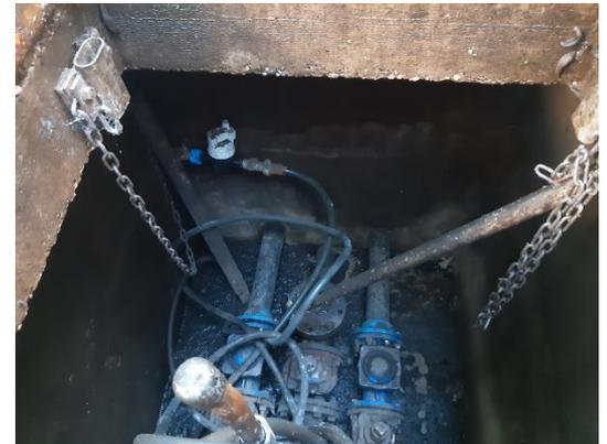
Figure 119 : Chambre à vannes/clapets
