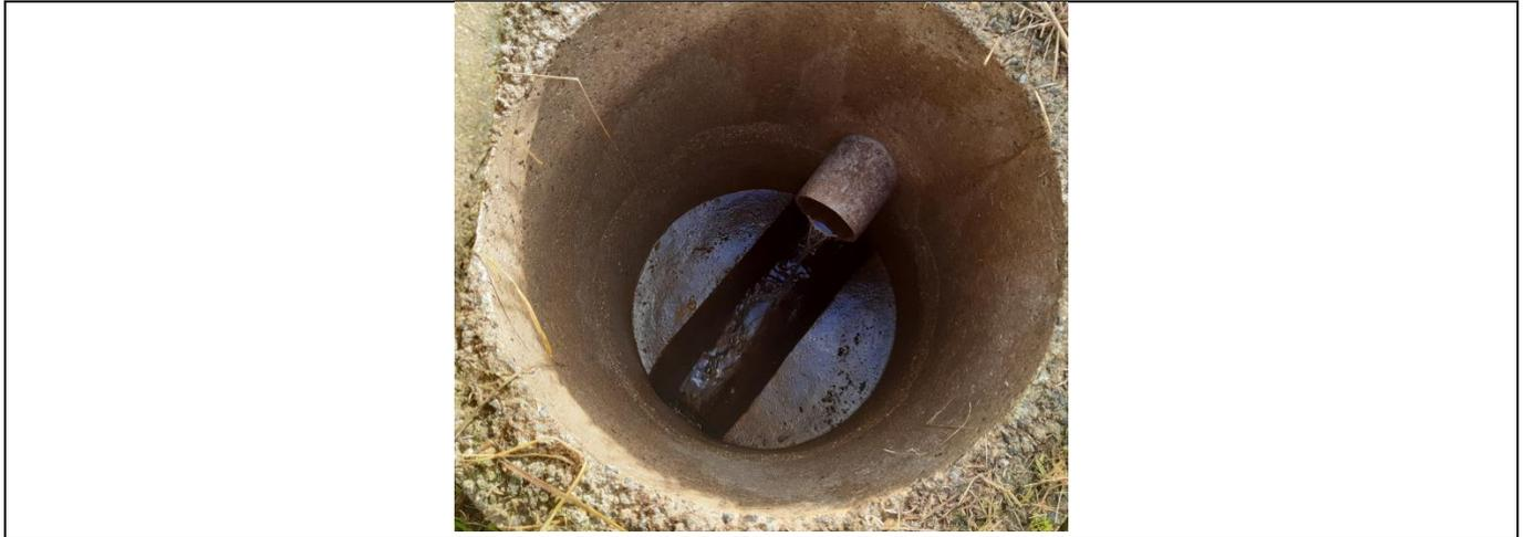
*Figure 130 : Photographie du regard de prélèvement*
