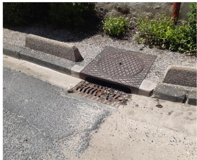
Figure 143 : Plan et photographie de l'avaloir en non-conformité
