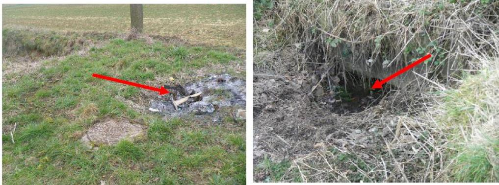
Figure 24 : Affaissement constaté au droit du réseau pluvial (à gauche) et affaissement au niveau de l'exutoire du réseau pluvial (à droite)
